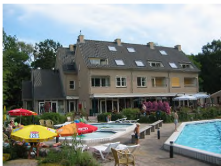
Centrumgebouw Bonte Vlucht Doorn
