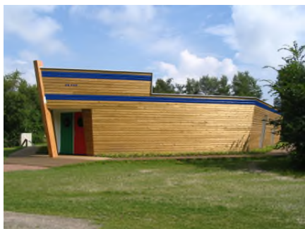
Sanitair gebouw De Potten Offingawier
